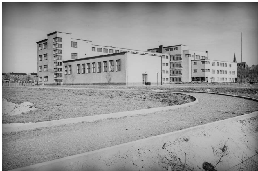
Il. 4. Szarlej. Budynek gimnazjum, fot. Henryk Poddębski, NAC, sygn. 3/131/0/-/340
