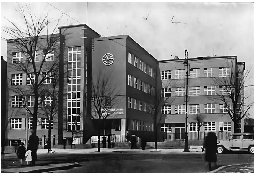
Il. 5. Królewska Huta (Chorzów), szkoła powszechna, proj. Wojciech Sobóń, cyt. za: „Architektura i Budownictwo”, nr 4-5/1937, s. 164
